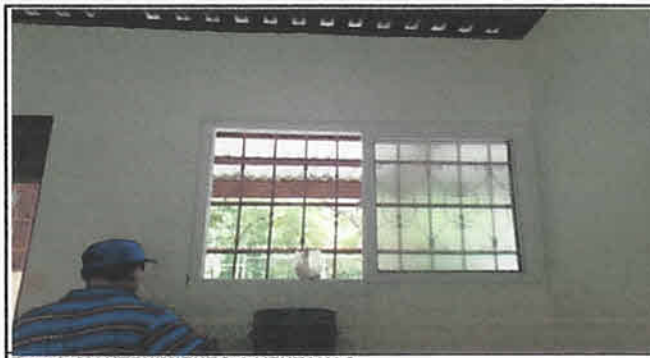
Foto 6: MANTENIMIENTO A VENTANAS
