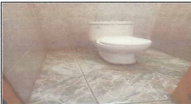
Foto 3: CAMBIO DE BAÑOS
