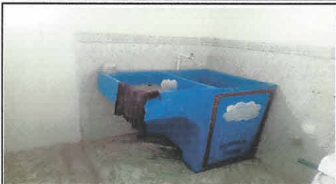
Foto1: INSTALACION DE PILA DE CEMENTO
