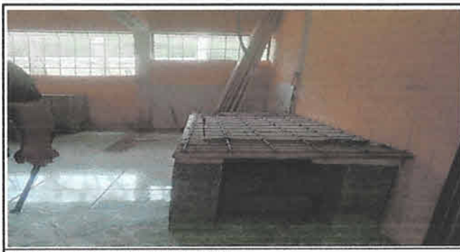
Foto 5: REMOZAMIENTO EN COCINA
